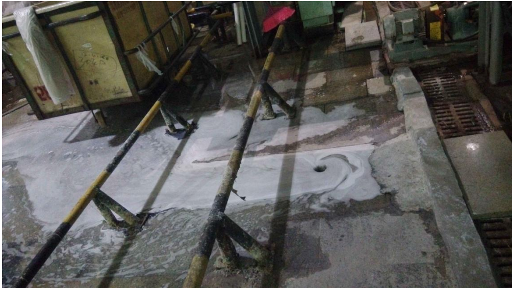
写真 10：排水が作業現場全体にあふれている
