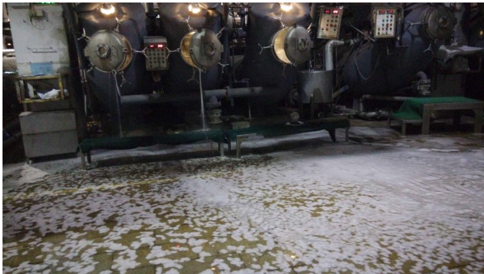
写真 9：排水が作業現場全体にあふれている
