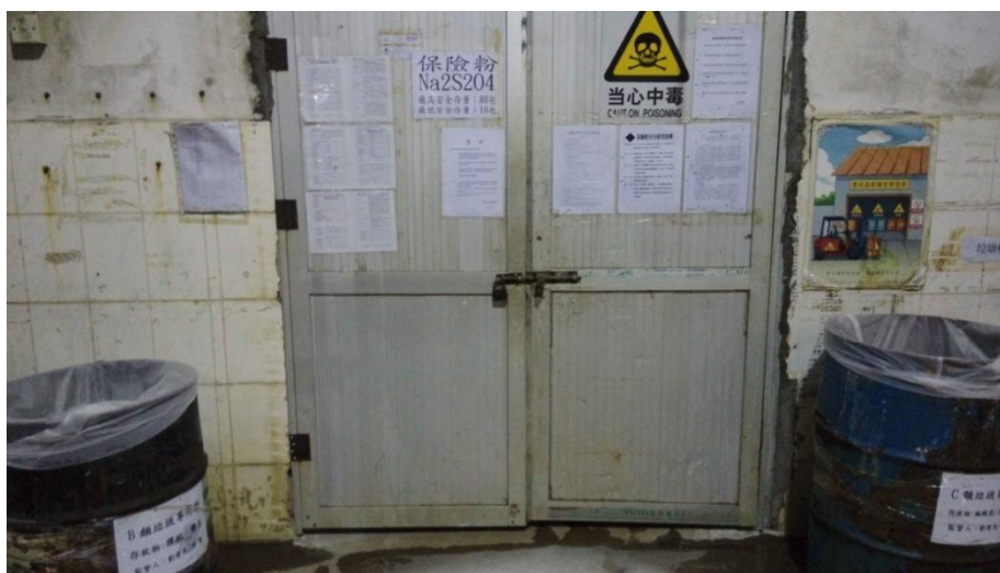
写真 12：有毒な化学物質が保管されている室内にも排水が流れ込んでいる。
