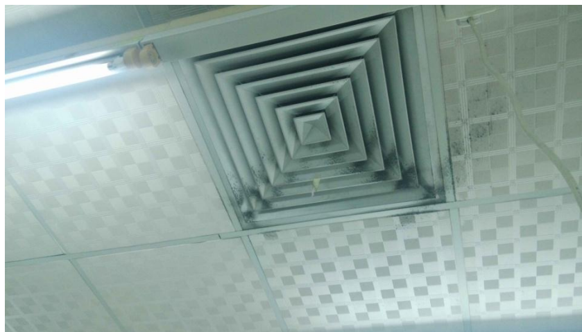
写真 15：集中空調設備は塞がれており、埃で溢れている。
